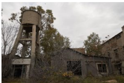
Το εγκαταλελειμμένο ακίνητο της ΧΡΩ.ΠΕΙ. στην Πειραιώς – Πηγή: Γ.Τ. Πρωθυπουργού/ Δημήτρης Παπαμήτσος
